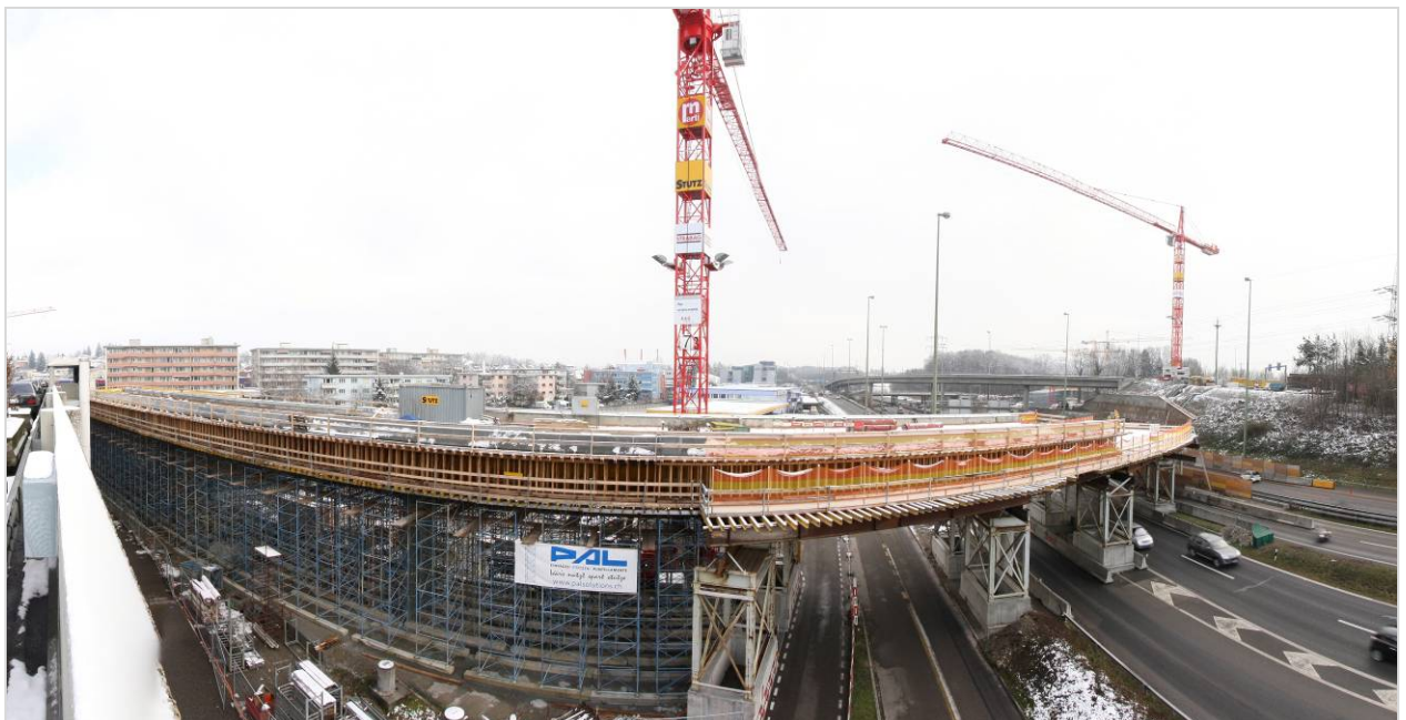
Abbildung 6: Bau 3. Etappe, Objekt Viadukt Glattzentrum
