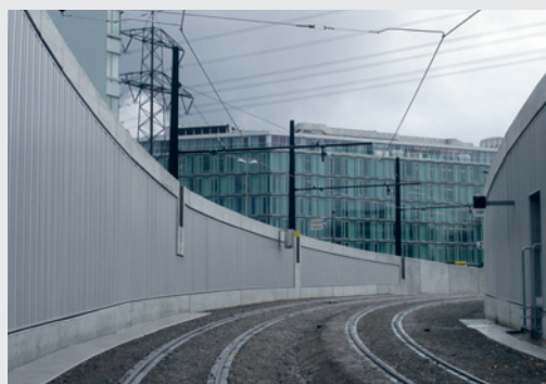
Abbildung 1: Lärmschutzmassnahmen beim Südportal des Margarethentunnels
