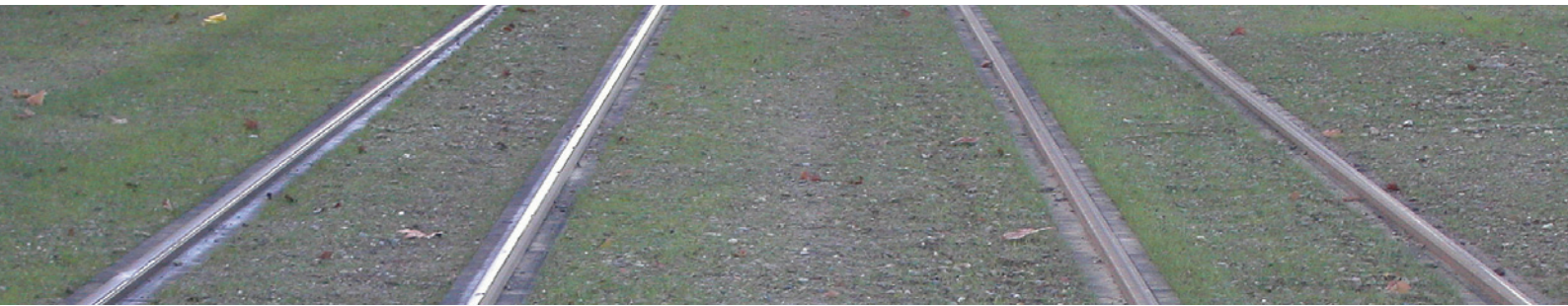
Abbildung 4: Schienenstränge der Glattalbahnh im Schotterrasen
