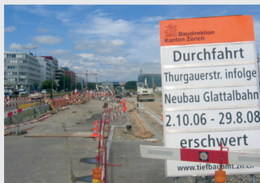
Abbildung 7: Signalisation der Verkehrswege
