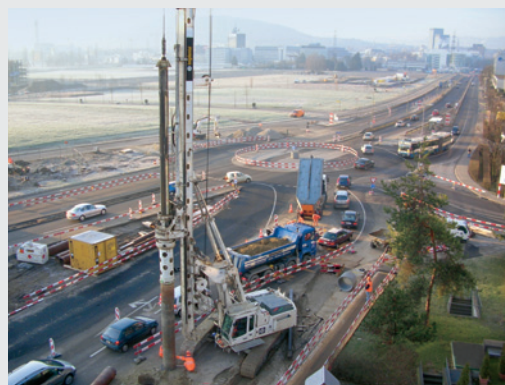
Abbildung 1: Bauen unter Verkehr
