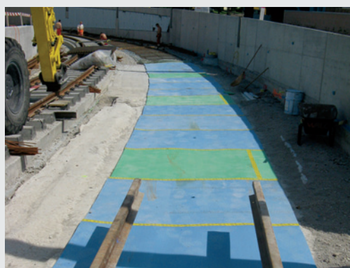
Abbildung 1: Einbau von Elastomermatten
