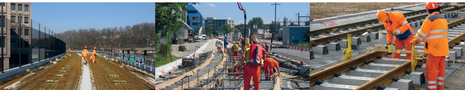
Abbildung 3: Die Entstehung des Gleisoberbaus
