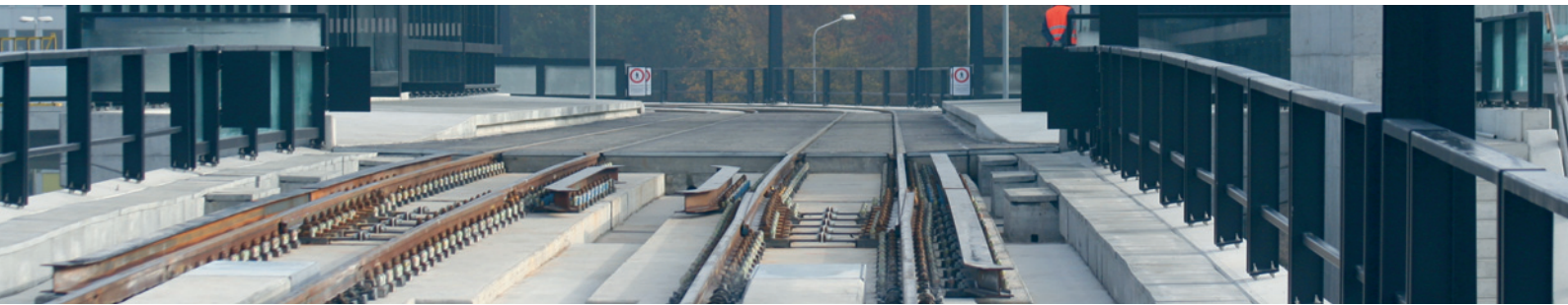
Abbildung 5: Schienenauszüge auf dem Viadukt Balsberg
