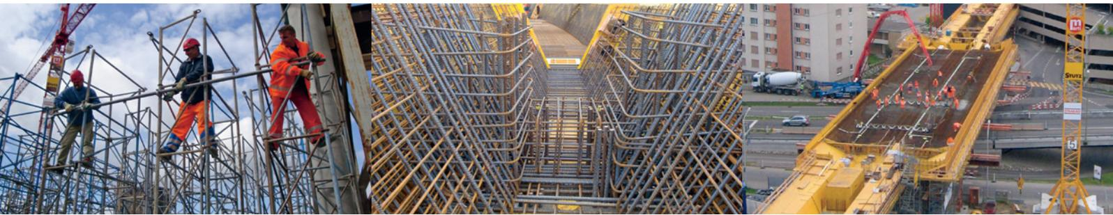
Abbildung 4: Konstruktion Lehrgerüst, Schalung und Armierung, Betonieren
