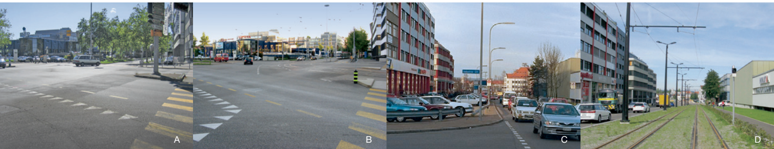
Abbildung 2: Zwei Situationen im Strassennetz vor und nach dem Bau der Glattalbahnen; als Ersatz für die Inanspruchnahme des Strassenraums durch die Glattalbahnen wurden die Fahrspuren erneuert oder gegebenenfalls sogar erweitert und neue Steuerungsanlagen installiert. Bilder vorher/nachher: A und B Airgate in Oerlikon, C und D Ringstrasse in Dübendorf
