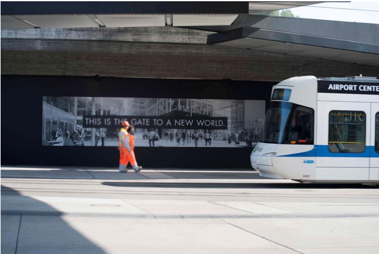
Hinter der Glattalbahn-Haltestelle: Die grösste Hochbaustelle der Schweiz
